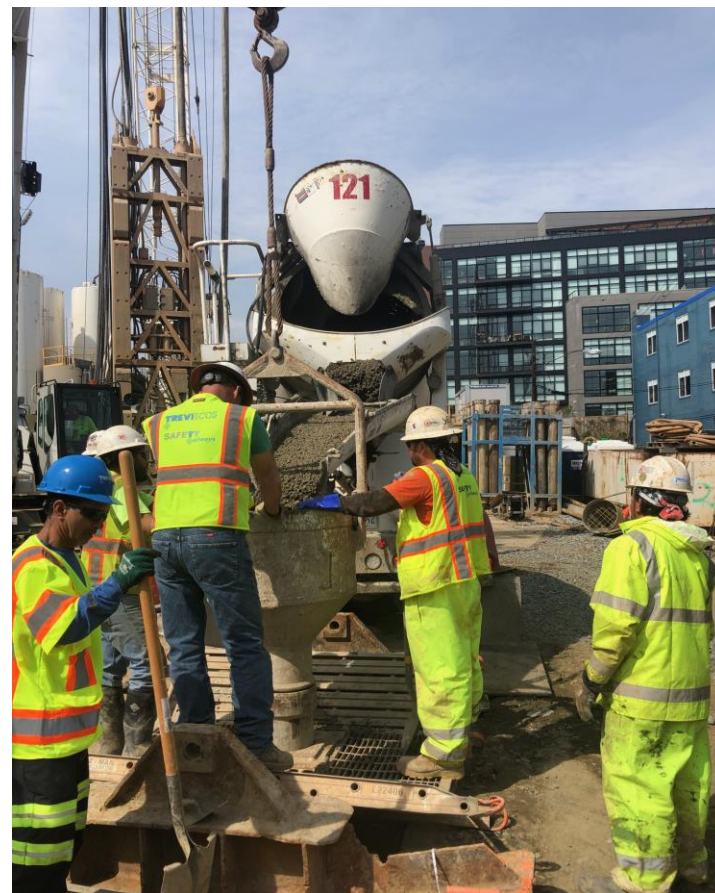
Concrete pour at Rhode Island Avenue NE
